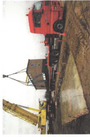
Installation de postes de livraison et de transformation
