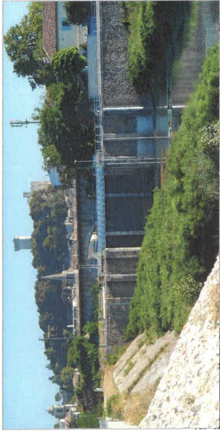
Figure 76 : Écluse n°1 de Beaucaire (Source : ARCAZE, 10 juillet 2019)
